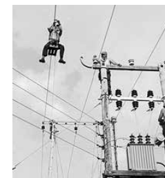
Syväsenvaaran 20 kilovoltin johtojen rakentamista.
