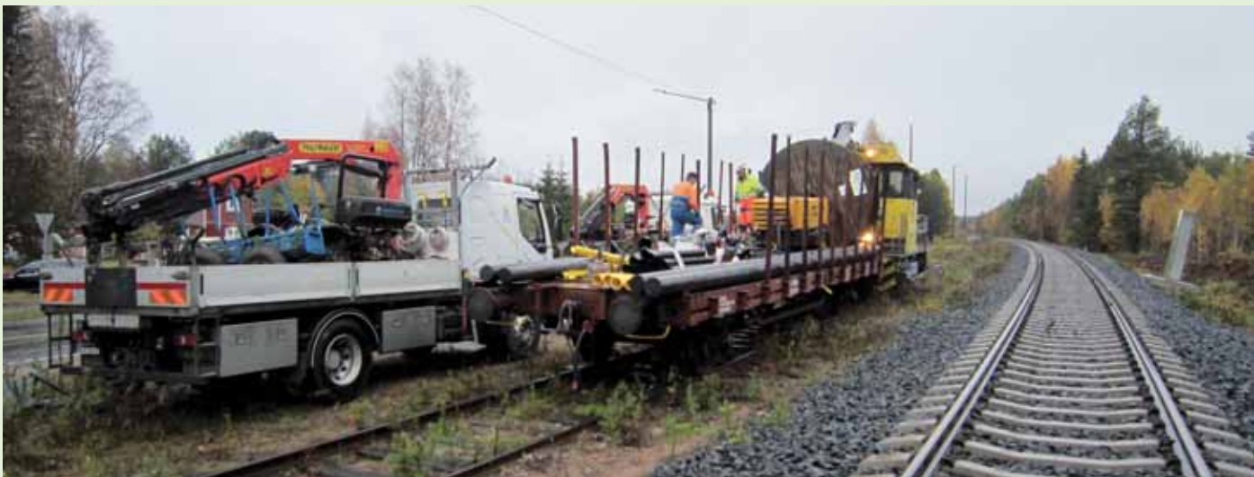
Kemijärven radan sähköistykseen valmistelua tehtiin mm. kaapeloimalla radan ylittävät ilmajohdot.
