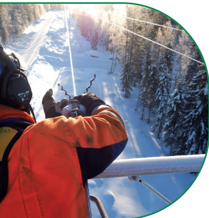
Sähköasentaja Matti Laajanen sitomassa johdinta eristimeen.
