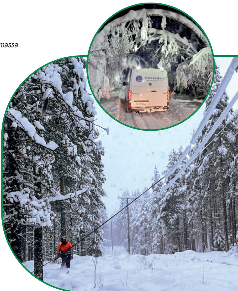
Tykkylumen pudottaminen on raskasta fyysistä työtä. Sähköasentaja Jori Laukkanen punnertaa.
