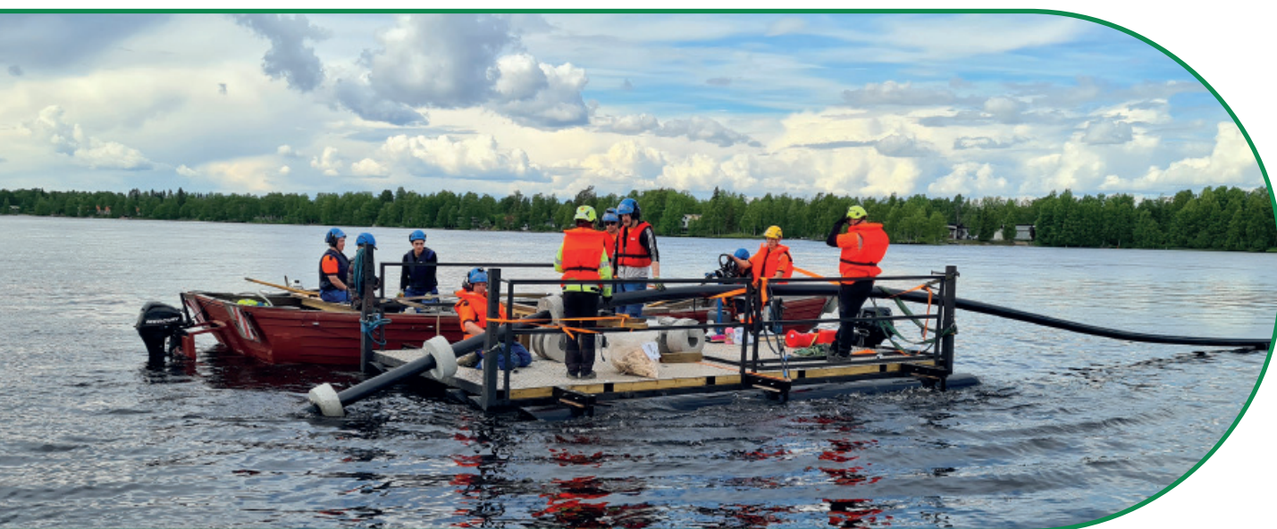
Kemijoen pohjaan asennettiin kaapeli kesäkuussa.
