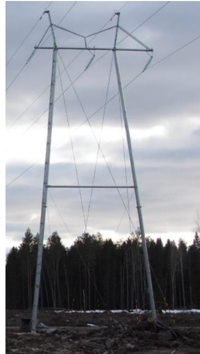
Kuva 2-1. Suunniteltu 110 kV voimajohto Kittilä-Putkijänkä (vas.) ja mallikuva teräsrunkoisesta harustetusta pylväästä (oik.; kuvat © TLT-Building Oy).
