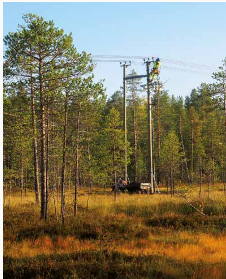
Wiski-kaapelin jomppien kytkeminen ilmajohtoon.
