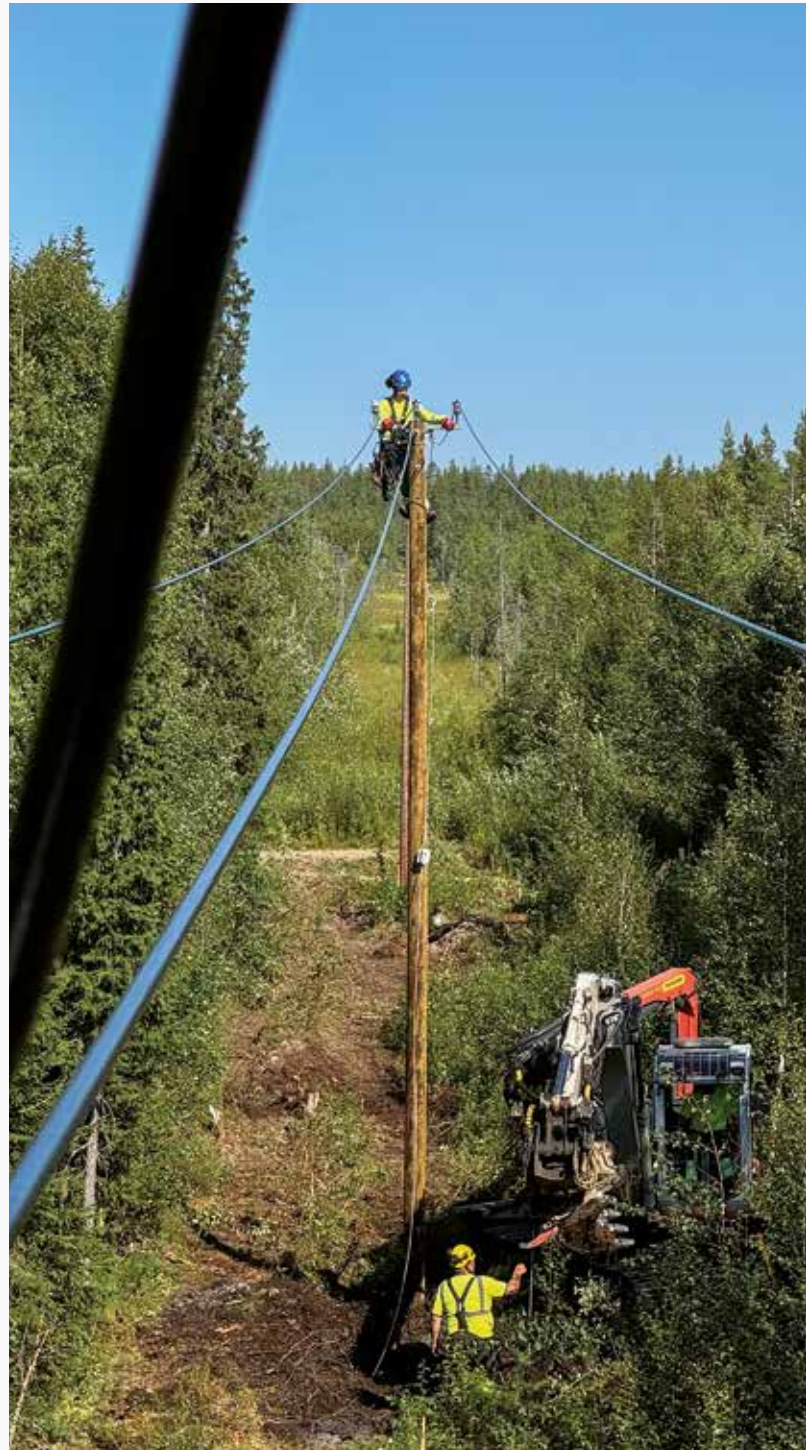
Asentaja sitoo lankoja uuden pylvään eristimelle.
