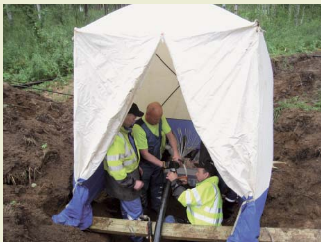
Olavi Aalto ja Veli Keränen asentamassa erikoiskaapelia, jossa sähkökaapeli ja valokaapeli ovat saman vaipan sisällä. Jari Mäenpää Enstolta seuraa vieressä (vas.).
