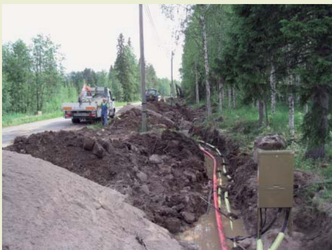
20 KV maakaapelin asennustyömaa.
