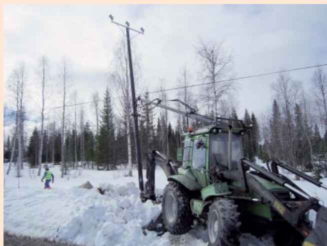
Ilmajohdon siirtoa tien varteen, työssä Ville Kinisjärvi.
